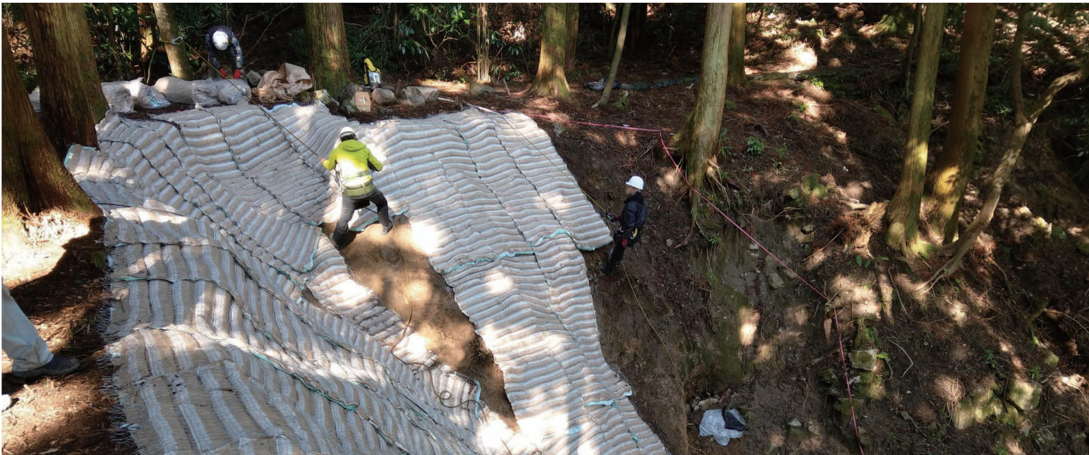
座主跡 災害応急復旧工事状況
