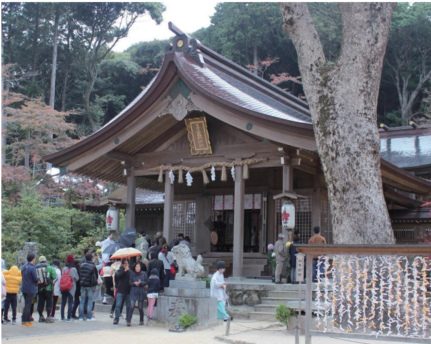
写真 3-34 禰門神社社殿 (平成 25 年改修後)
