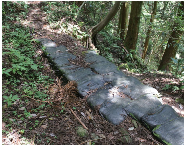
写真 3-30 水害箇所の土のう設置 (坊跡石垣)
