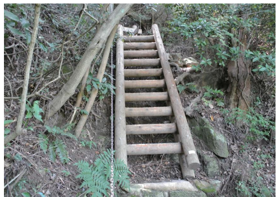
写真3-12 九州自然歩道の階段
