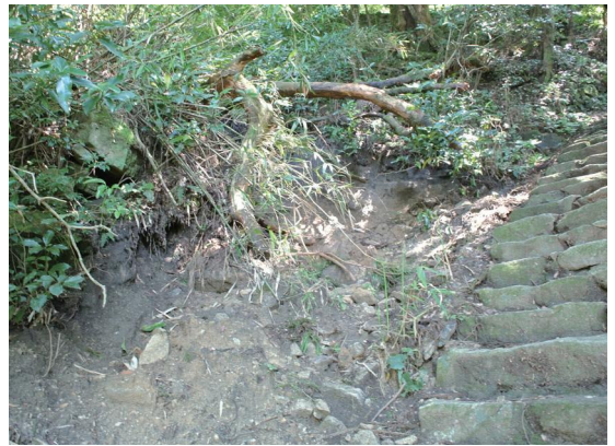
写真3-11 百段ガンギ横の崩壊
