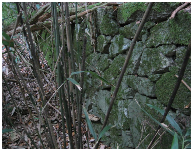
写真 3-14 西院谷坊跡の石垣
