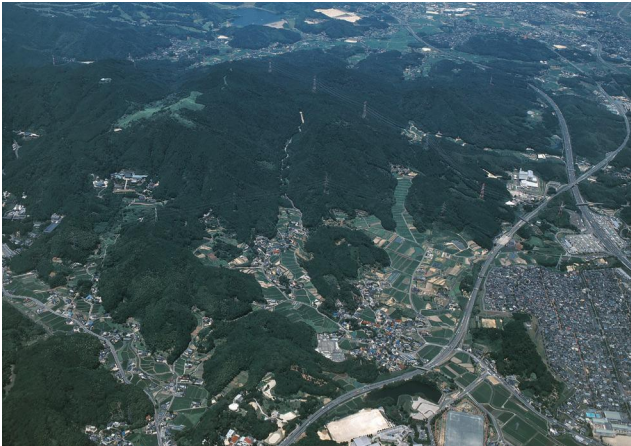
写真 2-1 基肄城跡(筑紫野市・基山町)
