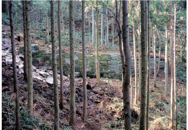
写真 2-5 阿志岐山城跡 第 3 水門（筑紫野市）
