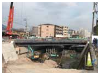
鷺田橋架設工事
