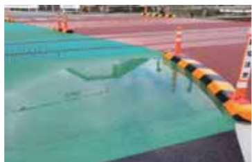
市の上踏切歩道部にできた水たまり(旧シルバー人材センター前)
