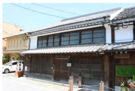
杉村家住宅 (かつて二階は鉄扉窓であったと伝えられています)
