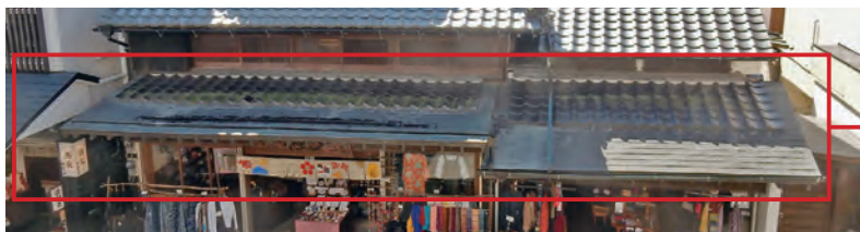
■下屋庇に瓦葺きと金属板葺きを併用したもの
