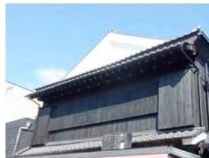
縦羽目板張り
