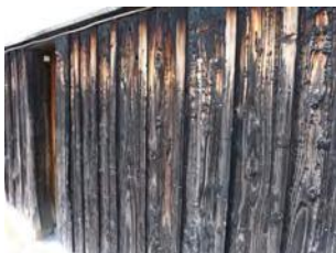
縦羽目板張り
