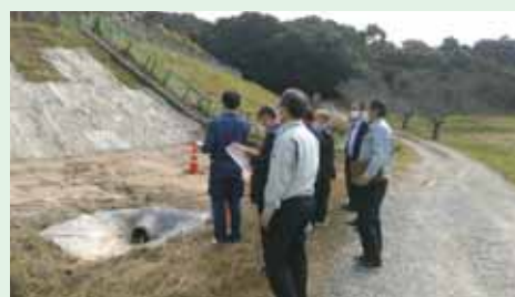
安之浦池の補修箇所
