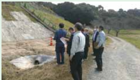
安之浦池の補修箇所
