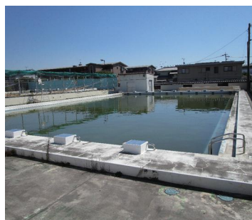
水城小学校のプール
