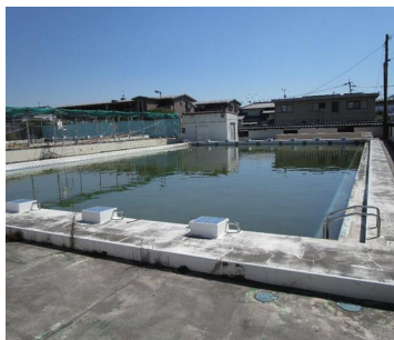
水城小学校のプール
