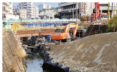
県道福岡日田線鷺田橋（都府楼団地郵便局付近）
