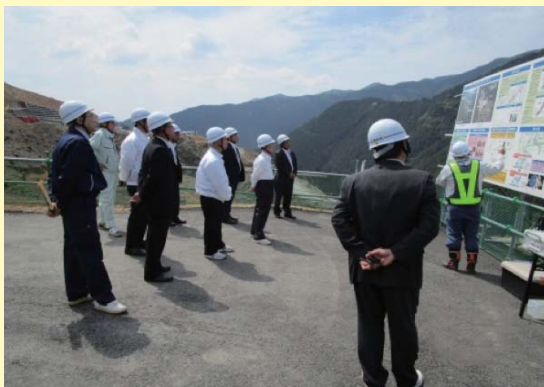
小石原川ダム建設現場
