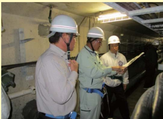
天神さま通り共同溝内部
