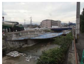
鶴田橋架け替え工事（県施工）
