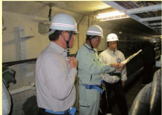
天神さま通り共同溝内部
