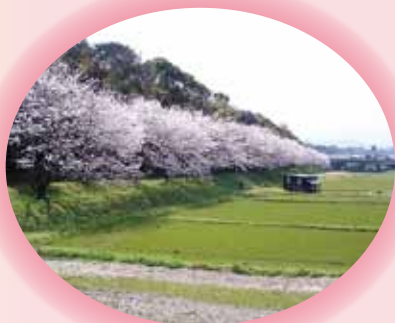
水城堤防(東側)
