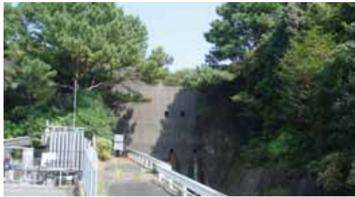
水城ヶ丘区砂防ダム
