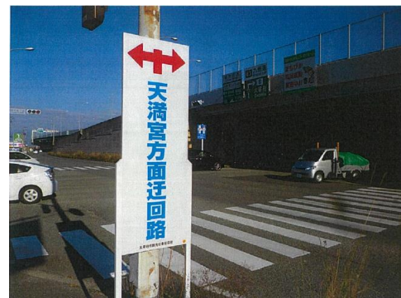
誘導看板の設置
