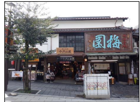
歴史的風致形成建造物保存修理 （保存修理後）
