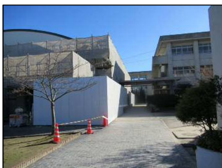
施工箇所全景
