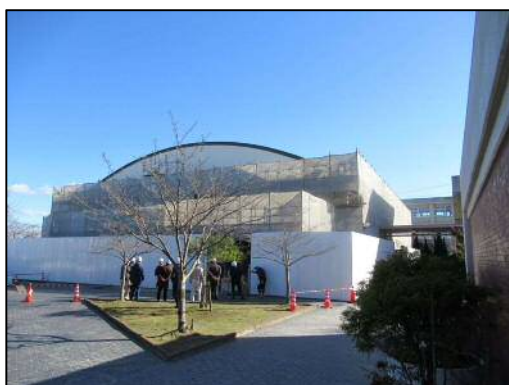
施工箇所全景
