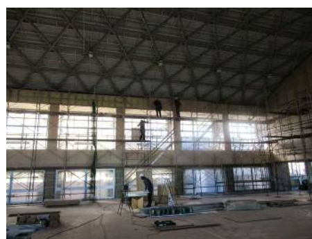
内部作業状況
