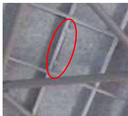
木毛板固定状況
