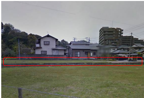
図 8-41:計画地に設置されている擁壁
