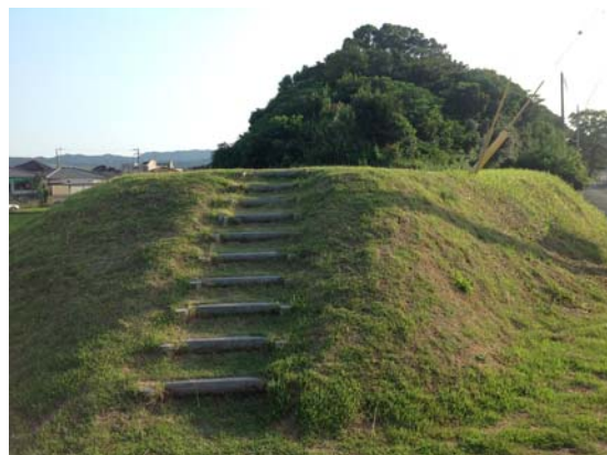
図 8-6: 階段の設置例(欠堤部外濠広場周辺)
