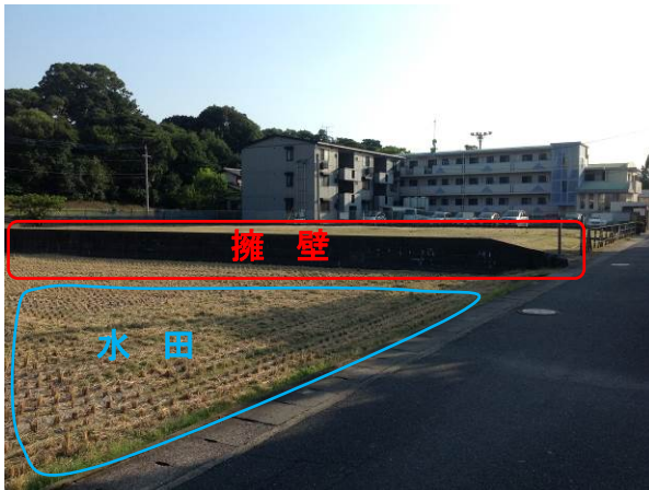
図 8-67: 擁壁と水田の状況
