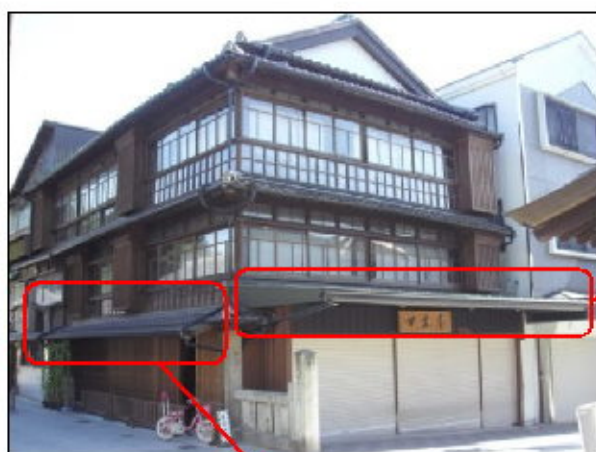
■下屋庇に瓦葺きと金属板葺きを併用したもの
