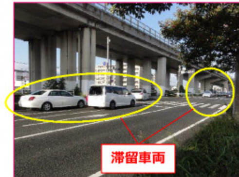
交差点から踏切への滞留状況
