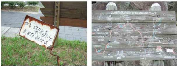
錆びてしまったサイン
