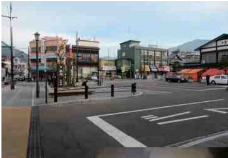
【整備後の太宰府駅前広場】
