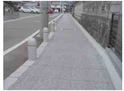
【整備後の溝尻雀田道路】
