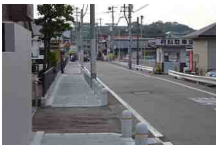
【整備後の溝尻雀田道路】
