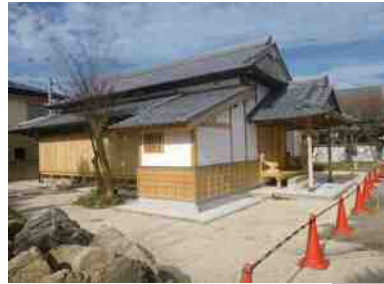
【修理された定遠館と土塀】
