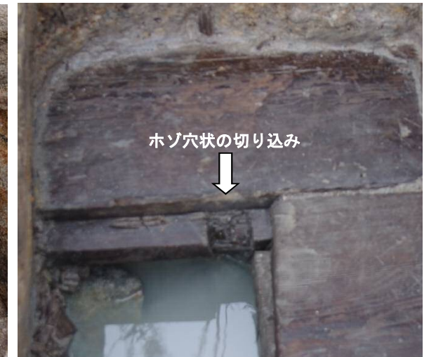
図11 木樋底板接合部(北東から)
