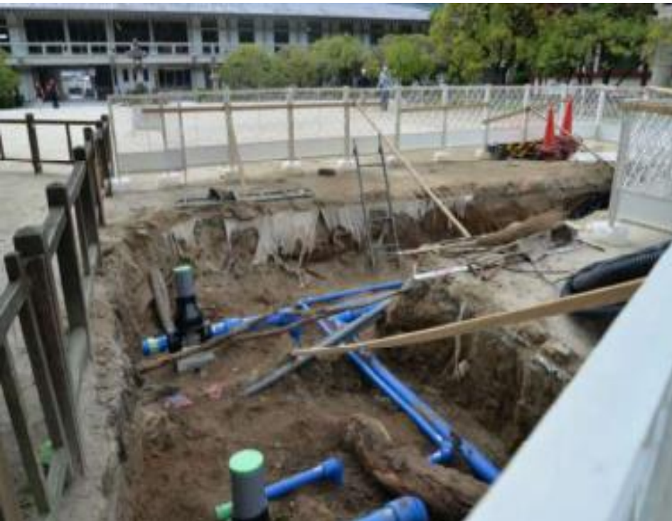
太宰府天満宮 防災施設整備（配管設置およびポンプ舎建設写真）
