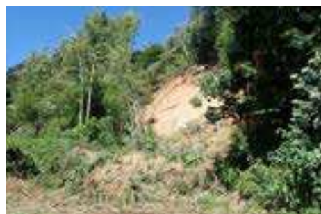
写4-2：月山東地区の崩落箇所
