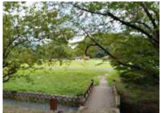
写4-14：バリアフリー環境が整っていない橋と園路 （政庁跡の西側）
