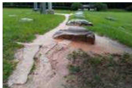
写4-1：毀損が目立つ正殿跡
