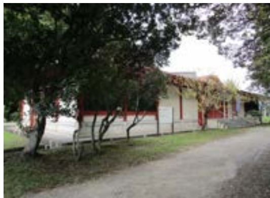
写4-25：樹木に囲まれた大宰府展示館
