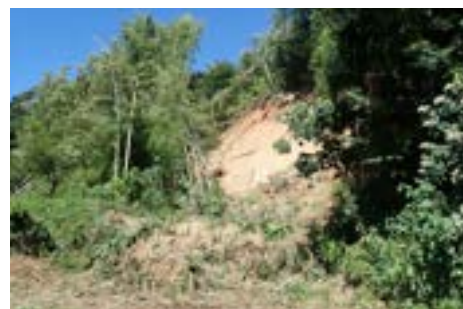
写4-2：月山東地区の崩落箇所
