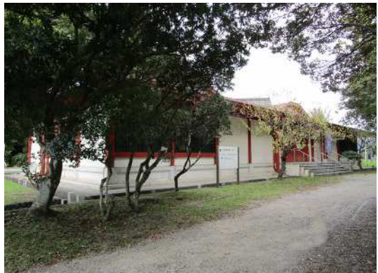
写4-25：樹木に囲まれた大宰府展示館
