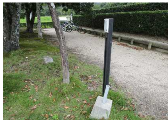
写4-20：破損した案内板の支柱
