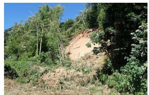
写4-2：月山東地区の崩落箇所
