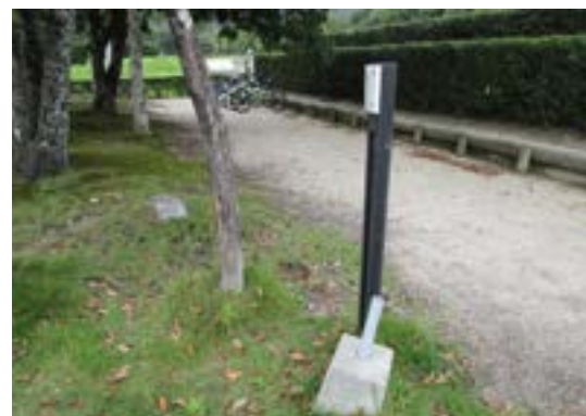
写4-20：破損した案内板の支柱
