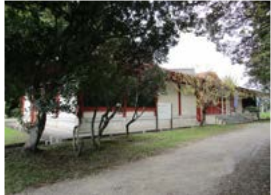
写4-25：樹木に囲まれた大宰府展示館
