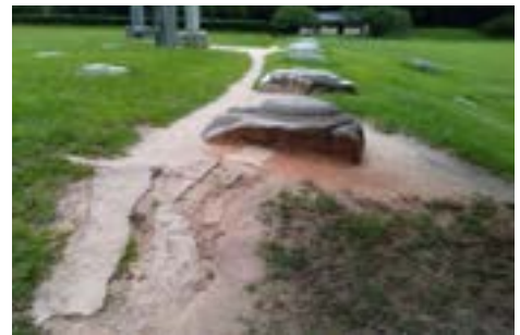
写4-1：毀損が目立つ正殿跡
