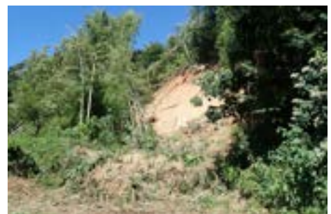
写4-2：月山東地区の崩落箇所
