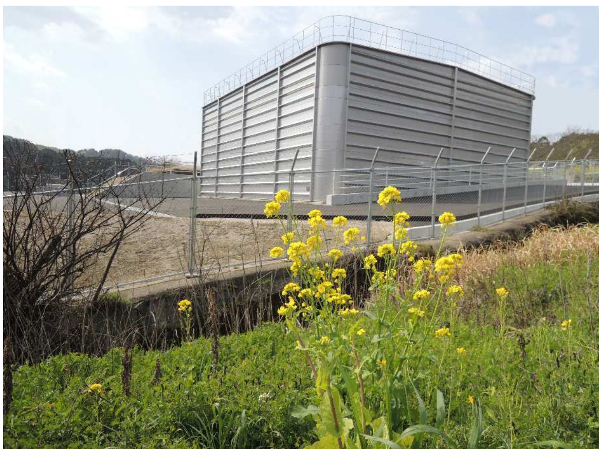
松川第2配水池
