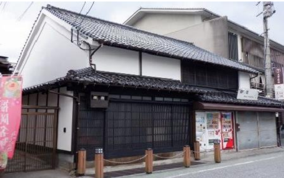
歴史的風致形成建造物（保存修理後）
