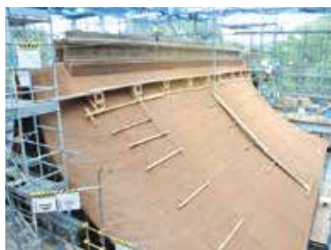
太宰府天満宮本殿の修理
