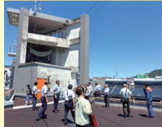
太宰府消防署の調査の様子
