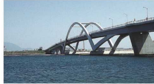
海の中道大橋(福岡市東区)
