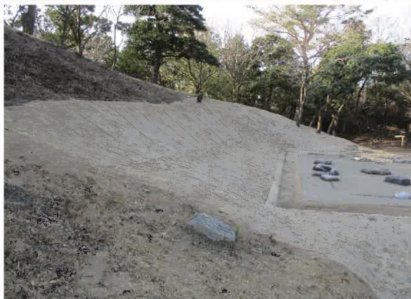
増長天礎石群法面整備
