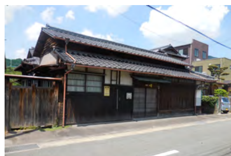
新町通りの残る町Ⅴ型の建築物 (屋根は瓦葺きに置き換わっています)
