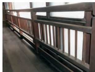
内付け手摺り
