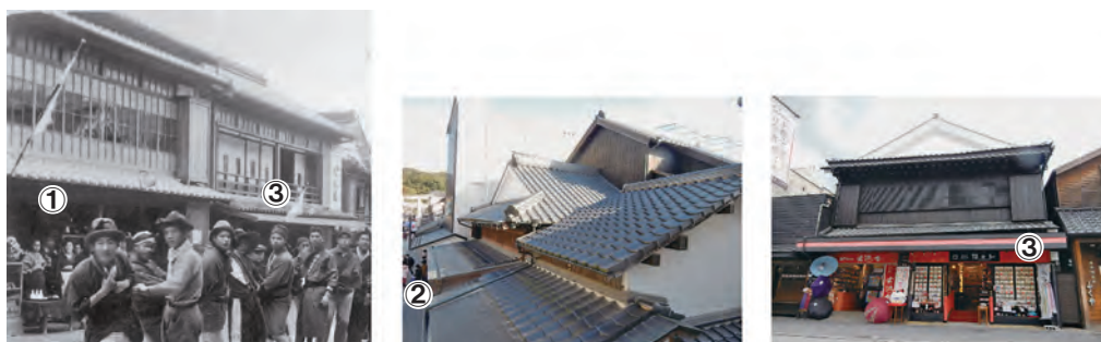
下屋庇等 (保全地区内)
