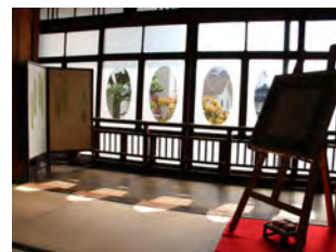
内付け手摺り
