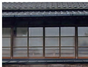
内付け手摺り
