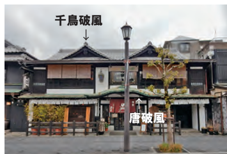
町Ⅲ型の建築物 (大和屋) (大和屋の2階に施工された2ヶ所の千鳥破風、1階の唐破風は後補された意匠です)
