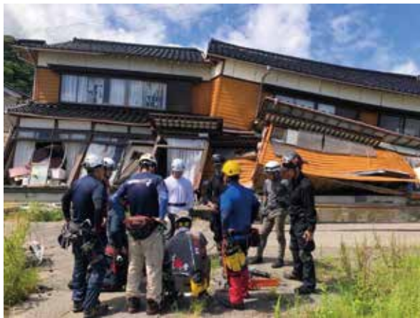
倒壊した家屋の撤去に集まった人
