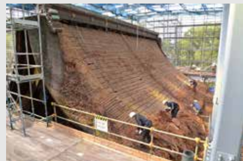
太宰府天満宮本殿の修理
