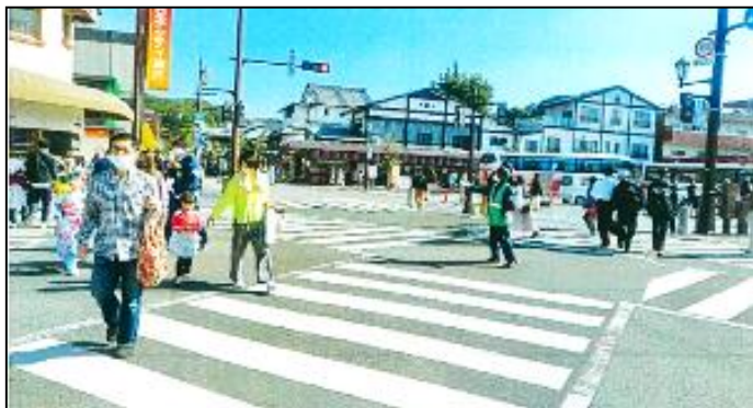
交通誘導警備員の配置
