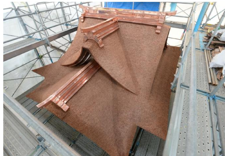
太宰府天満宮末社志賀社本殿屋根工事
