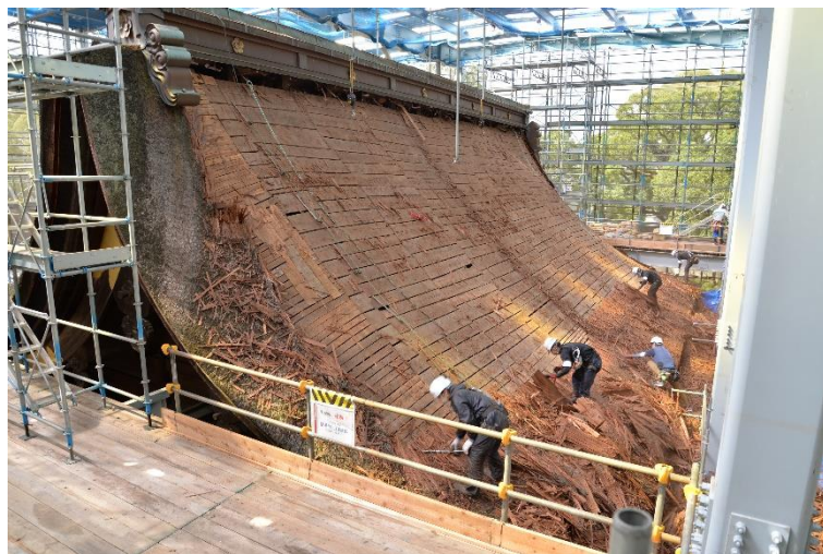
太宰府天満宮本殿屋根工事
