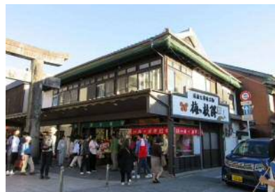
松尾家店舗 (修理後)
