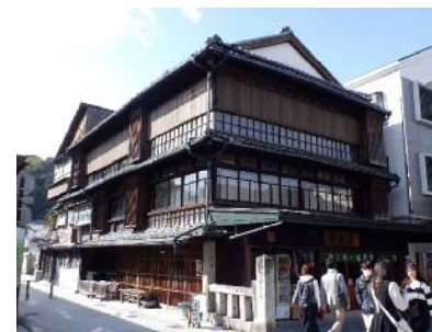
甘木屋 (修理後)
