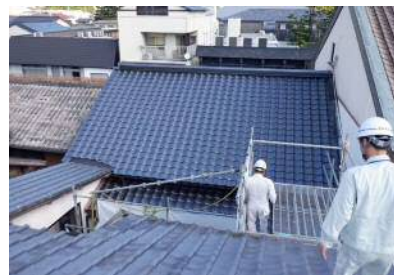
小野家店舗 (屋根修理後)
