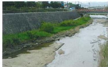
昭和47・8年の洪水以後御笠川の河川改修が行われるようになり、蛇行していたものが直線的で広い川幅を持つ現在のような川筋になった。河床中央の一部に昔の護岸が残っている。
