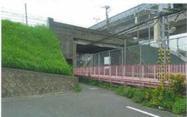
昭和7年に国道3号線(現県道112号線)が新設された。関屋付近では西鉄大牟田線を跨ぐ橋が造られた。橋の両側には大量の盛土が必要となり、近くの梅山という丘陵が削られ運ばれた。現在でも僅かにその丘陵が残っている。
