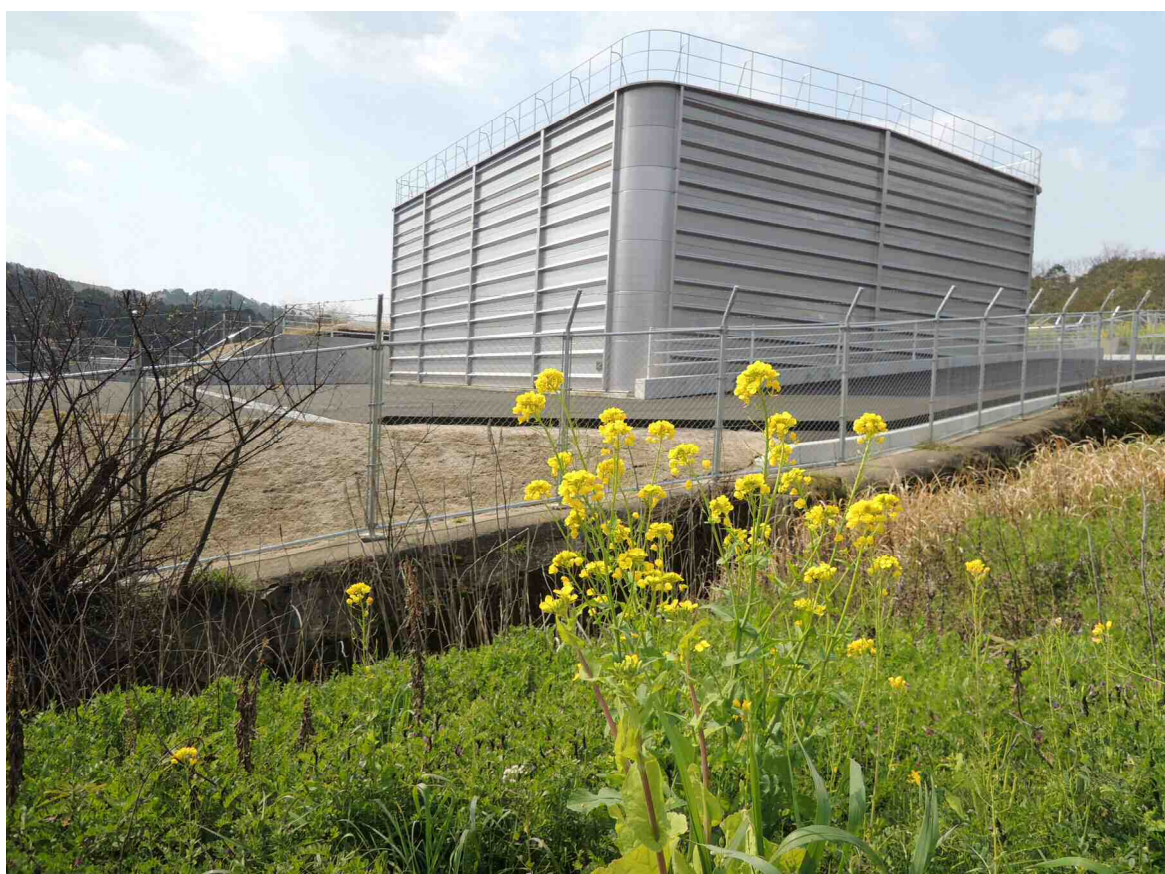
松川第2配水池
