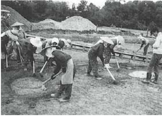
昭和43(1968)年に大宰府政庁跡で始まった発掘調査の様子(写真提供 九州歴史資料館)
