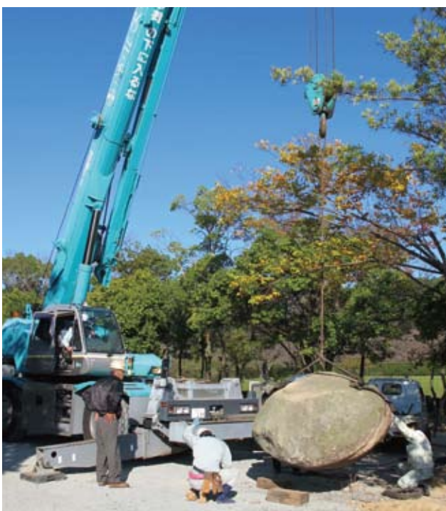
▲礎石の移設風景
