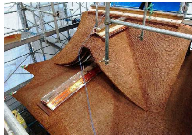
末社志賀社本殿 屋根工事 平葺完了（正側面）
