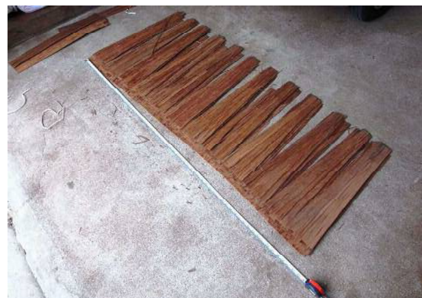
太宰府天満宮本殿 屋根工事 檜皮材料検査
