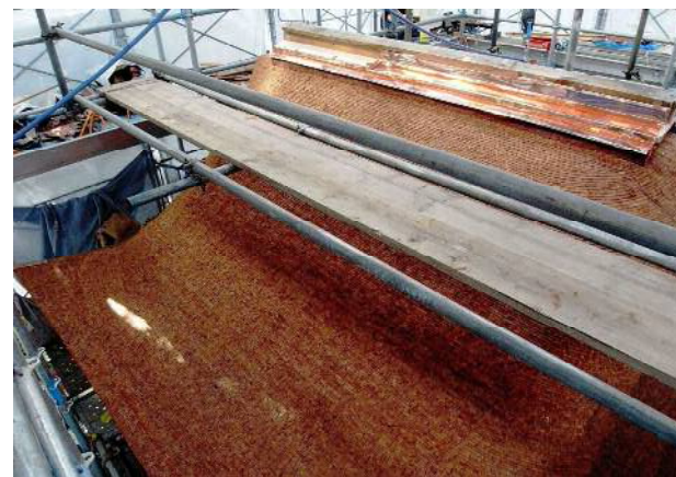
末社志賀社本殿 屋根工事 平葺完了（背面）
