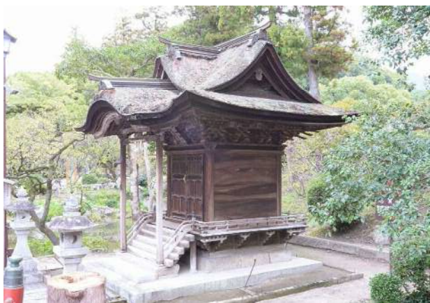
仮設工事 正面 木柵撤去完了
