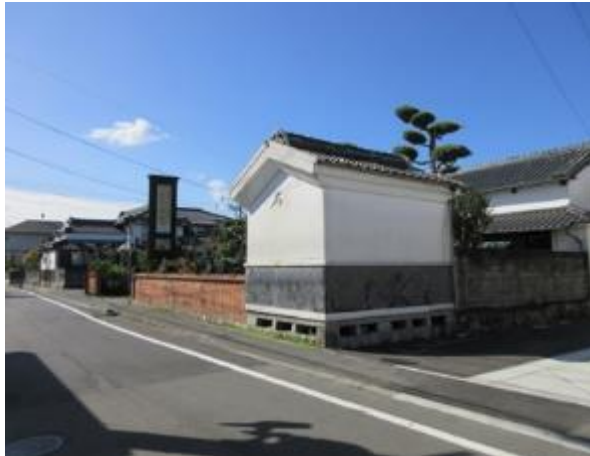
歴史的風致形成建造物 （保存修理前）
