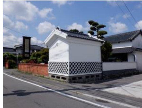
歴史的風致形成建造物 （保存修理後）
