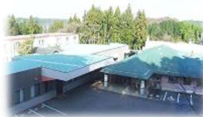
施設の外観です
