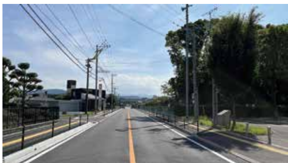
工事を完了して両側歩道になった道路
