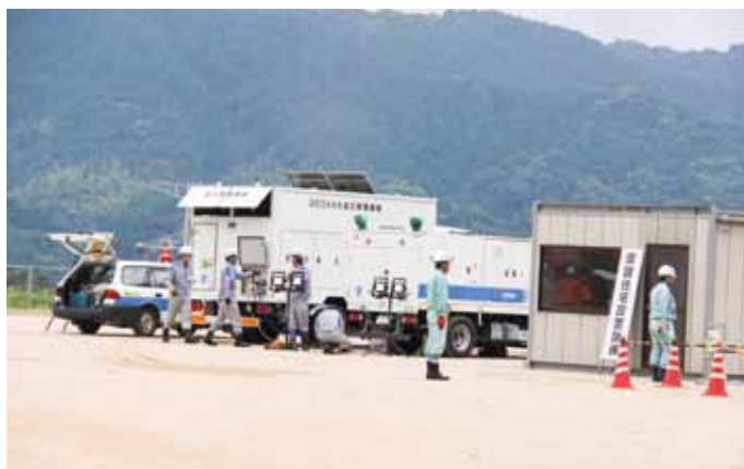
仮設住宅設置訓練
